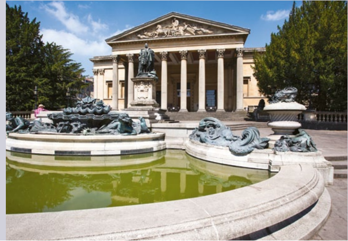
View of the Victoria Rooms Εξωτερική άποψη των Αιθουσών Victoria
