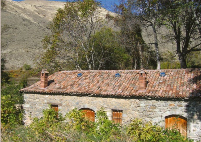
Exterior of the watermill after restoration Άποψη του νερόμυλου μετά από τις εργασίες αποκατάστασης
