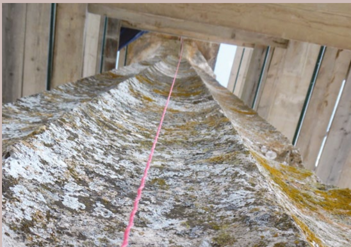
Testing the vertical alignment of a column, Temple of Zeus, Nemea Έλεγχος κατακορυφότητας κίονα από τον Ναό του Διός στη Νεμέα
