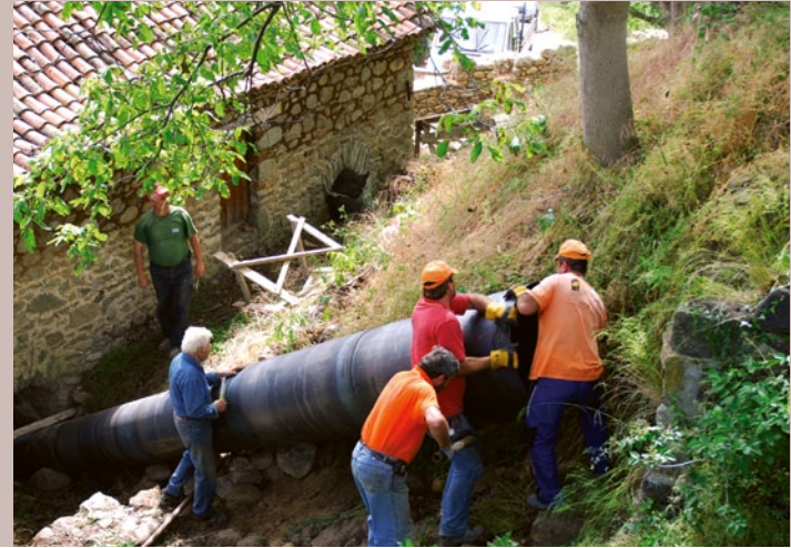
Installation of one of three metal pipes supplying water to the mill Τοποθέτηση ενός από τα τρία μεταλλικά βαράρια που διοχετεύουν νερό στον μύλο
