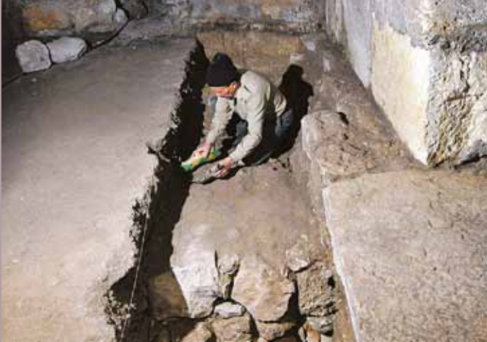
Εργασίες αναστήλωσης Ιερού Ναού Αγίου Ιωάννη του Βαπτιστή Restoration works at St John The Baptist Church
